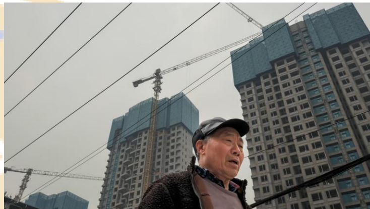
Ảnh: Các tòa chung cư cao tầng đang được xây dựng tại Trùng Khánh, Trung Quốc
