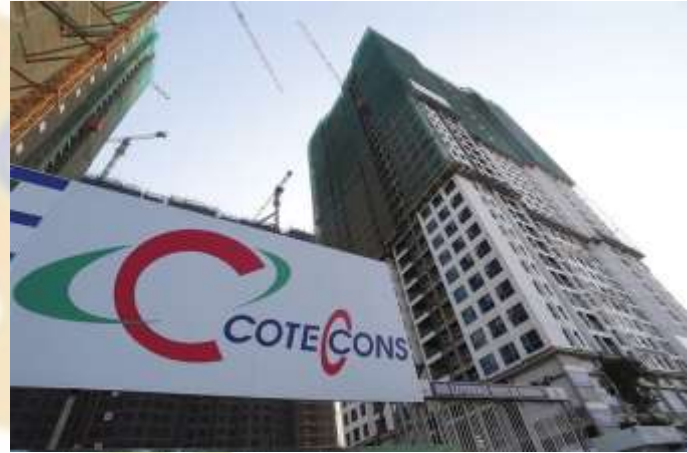
Ảnh: Công trường xây dựng một dự án có sự tham gia của Coteccons
