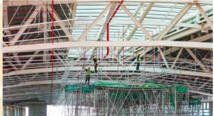
Ảnh: Công nhân thi công mái nhà ga sân bay Long Thành
