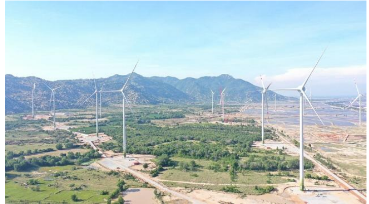
Ảnh: Nhà máy điện gió 7A, Ninh Thuận
