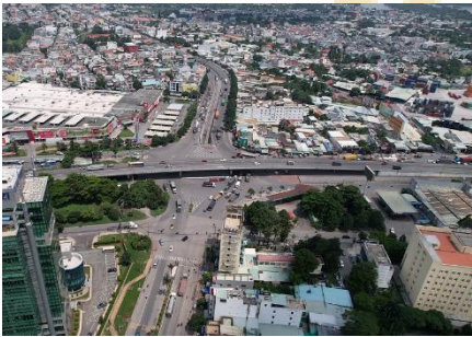
Hiện trạng đường trên cao dọc Quốc lộ 51
