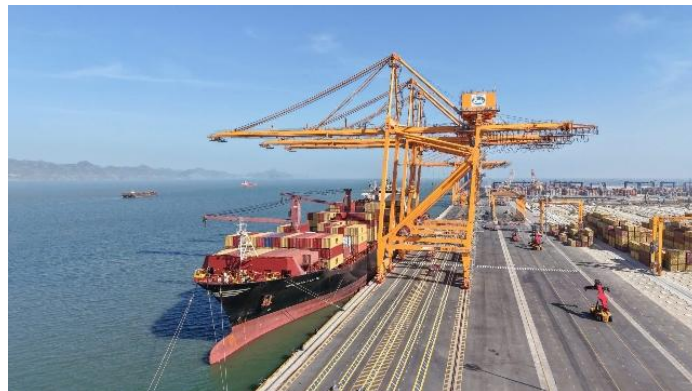
Hạ tầng bến cảng số 3 và 4 do PHP đầu tư tại khu vực cảng nước sâu quốc tế Lạch Huyện, TP Hải Phòng
