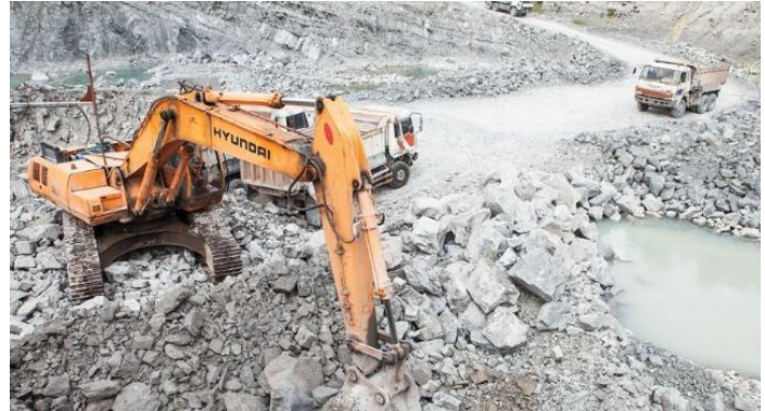
Hóa An hoạt động trong lĩnh vực khai thác đá xây dựng tại khu vực thành phố Đồng Nai, với các mỏ đá đang hoạt động gồm Tân Cang 3, Thạnh Phú 2, Núi Gió 2.
