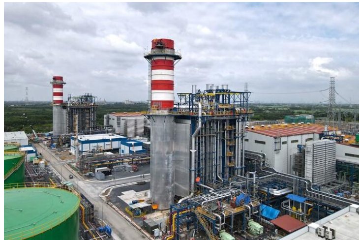
Nhà máy nhiệt điện Nhơn Trạch 3&4. (Nguồn: Lilama).
